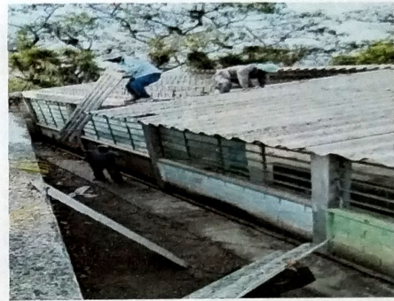
Foto 2: MODULO A Vista de desmontaje de cubierta de asbesto.
