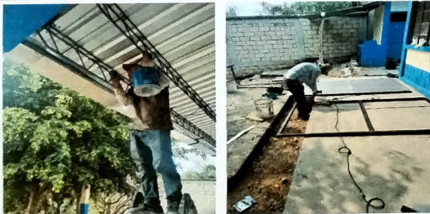
Foto 9: VISTA de Mantenimiento a Josit y fabricacion de porton de metal
