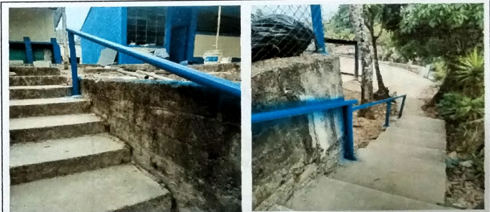
Foto 10: VISTA DE BARANDA METALICA en gradas existentes.
